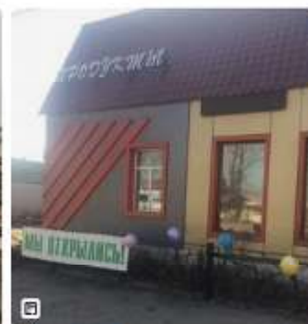
Здание, 400 м 2 9 277 000 Р 23 193 Р за м 2 ул. Стальная Протока, 35 р-н Советский 2 августа 2023
